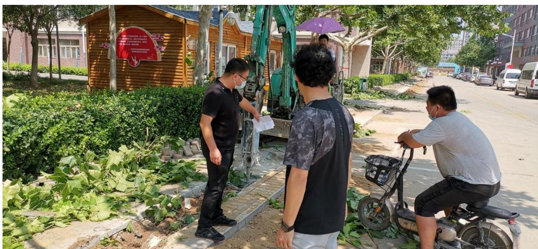
2、8月10日，现代教育技术中心主任、杨胜平老师、中国电信管网设计人员及管网施工负责人等，就学校出口路由问题进行实勘，由于该路段开挖难度较大，误伤已有管线风险较高，因此考虑顶管方式，具体方案正在抓紧研讨。
